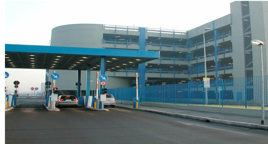
Attuale parcheggio di interscambio a San Donato (M3)
